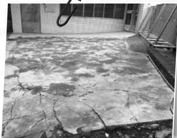
東側門地坪改善前
