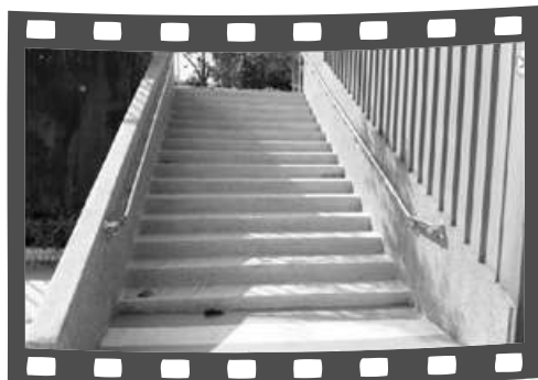
風雨教室階梯改善後
