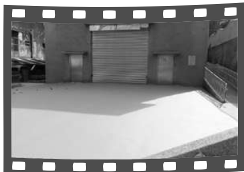
風雨教室地坪改善後
