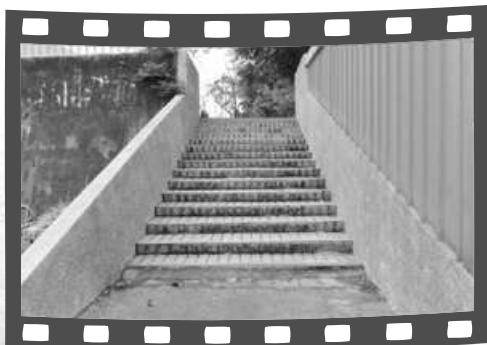
風雨教室階梯改善前
