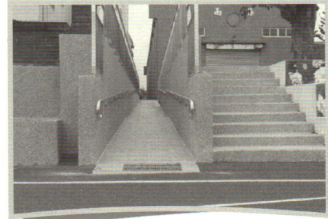
新設無障礙坡道
