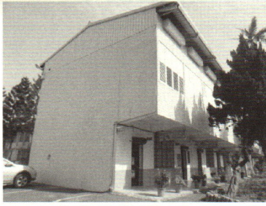
水美樓耐震補強 及外牆防水美化
