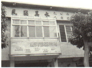
水美樓耐震補強及 陽台玻璃屋更新
