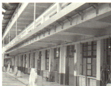
104年度校舍防水 ~工程改善後
