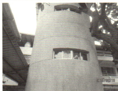
104年度校舍防水 ~工程改善後
