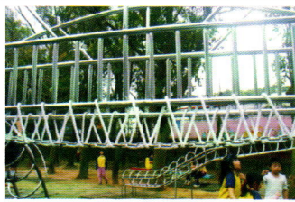
更「安全」的「遊樂設施」
