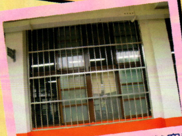
新增購不鏽鋼鐵窗，使學校教學設備免於遭竊，讓硬體設備發揮功效
