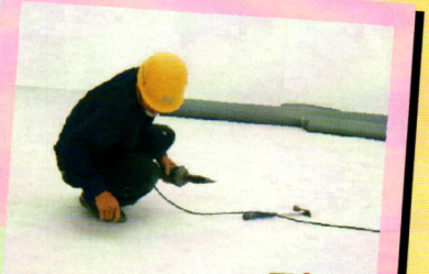
圖書室屋頂防水防漏工程，讓師生有優質的閱讀環境
