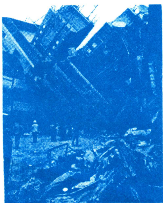
東勢的東勢王朝大樓於地震時倒塌，橫躺於道路中。
